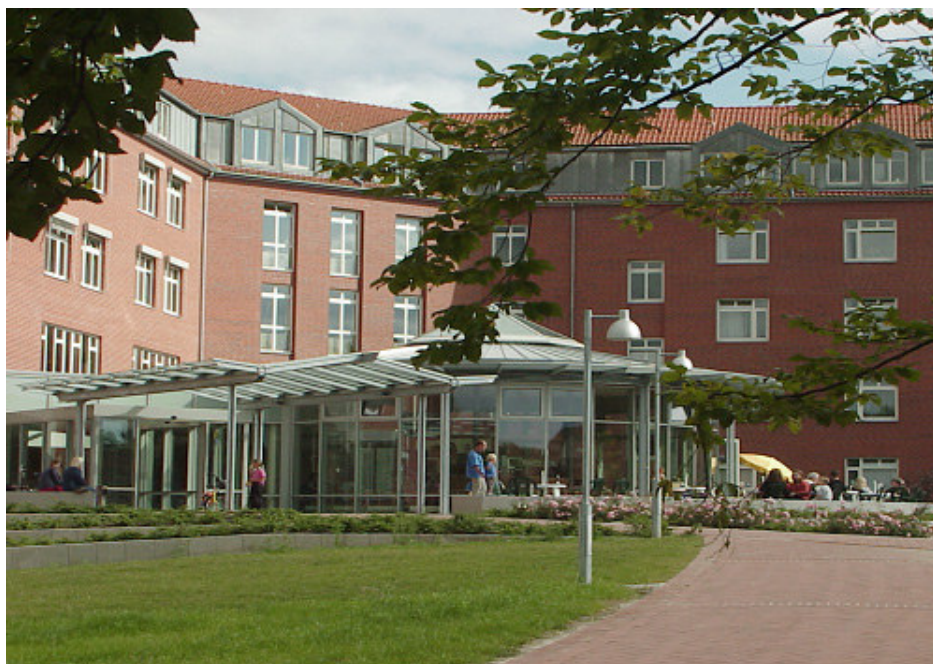
Heidekreis-Klinikum, Krankenhaus Walsrode mit Sicht auf den Eingangsbereich
